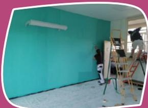
Travaux de peinture, d'isolation des combles, changement de mobilier. Modification des éclairages et dalles de plafond. Ajout d'un système de ventilation comme le demande la norme en matière de recyclage d'air (un air neuf de 15m<sup>3</sup> par heure et par personne).
